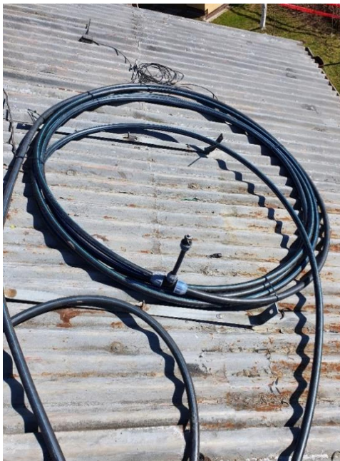
Obr. 1 Jednoduchý model kolektorového ohrevu vody
