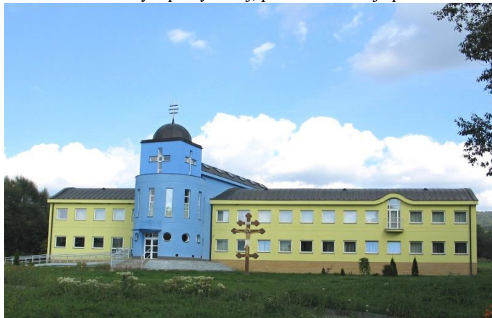
Obr. 1 Pohľad na budovu Monastyru Krásny Brod
