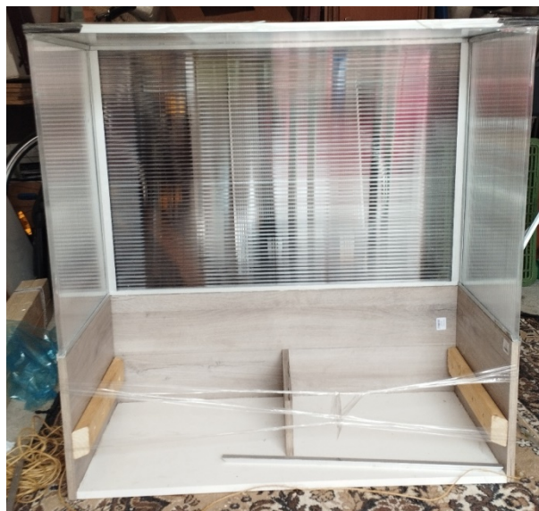
Obr. 6 Montáž konštrukcie skleníka- pohľad spredu.
